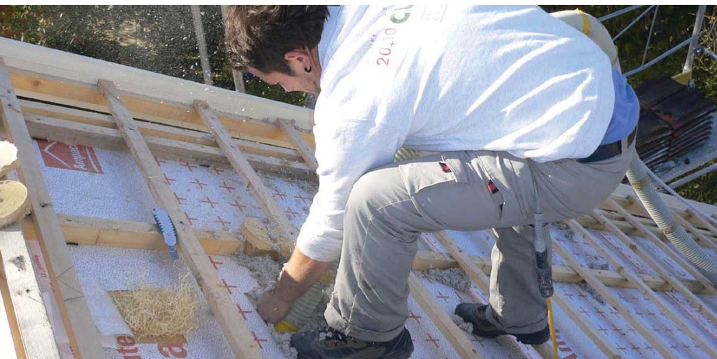
Der alte Dachstock wurde luftdicht eingepackt und gedämmt.
