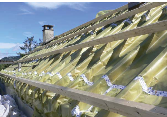
Der alte Dachstock wurde luftdicht eingepackt und gedämmt.
